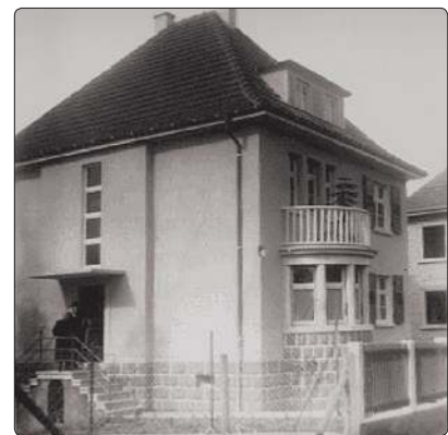
Glücklicherweise gab es historische Aufnahmen aus der Bauzeit.
