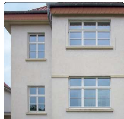
Dreibahnige Fenster ohne feststehende senkrechte Hölzer waren bis in die 1950er sehr gebräuchlich. PaXretro bietet hierfür den doppelten Stulp – auch bekannt als „Berliner Fenster“.
