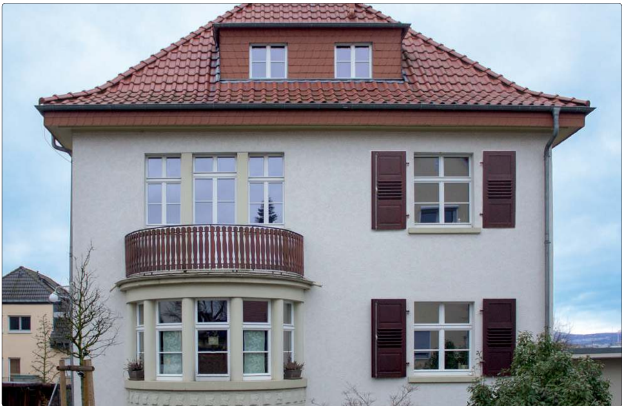
Nach der Sanierung mit PaXretro78
