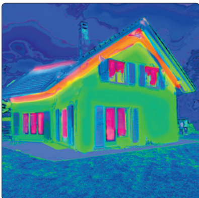
Eine Wärmebildkamera entlarvt veraltete und undichte Fenster.
